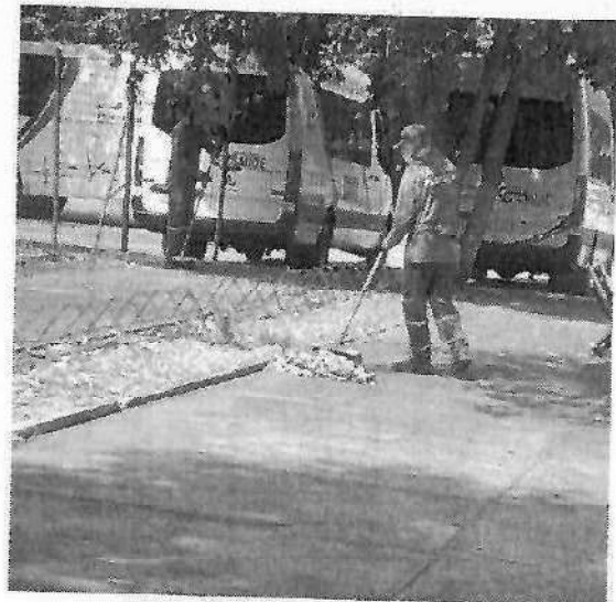
Limpeza da via asfáltica;
