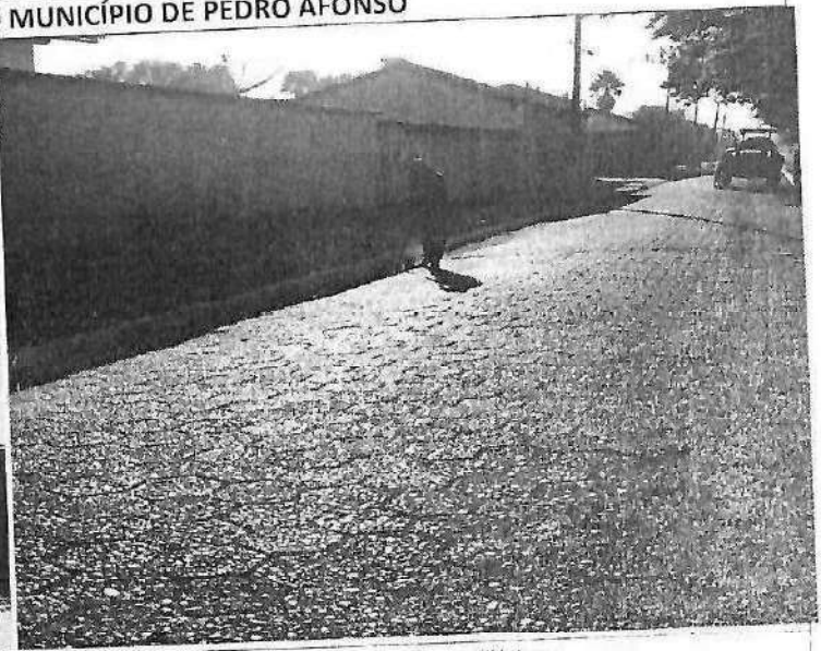
Limpeza da via asfáltica;
