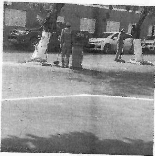
Limpeza da via asfáltica;
