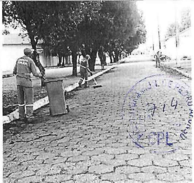
Limpeza da via asfáltica;
